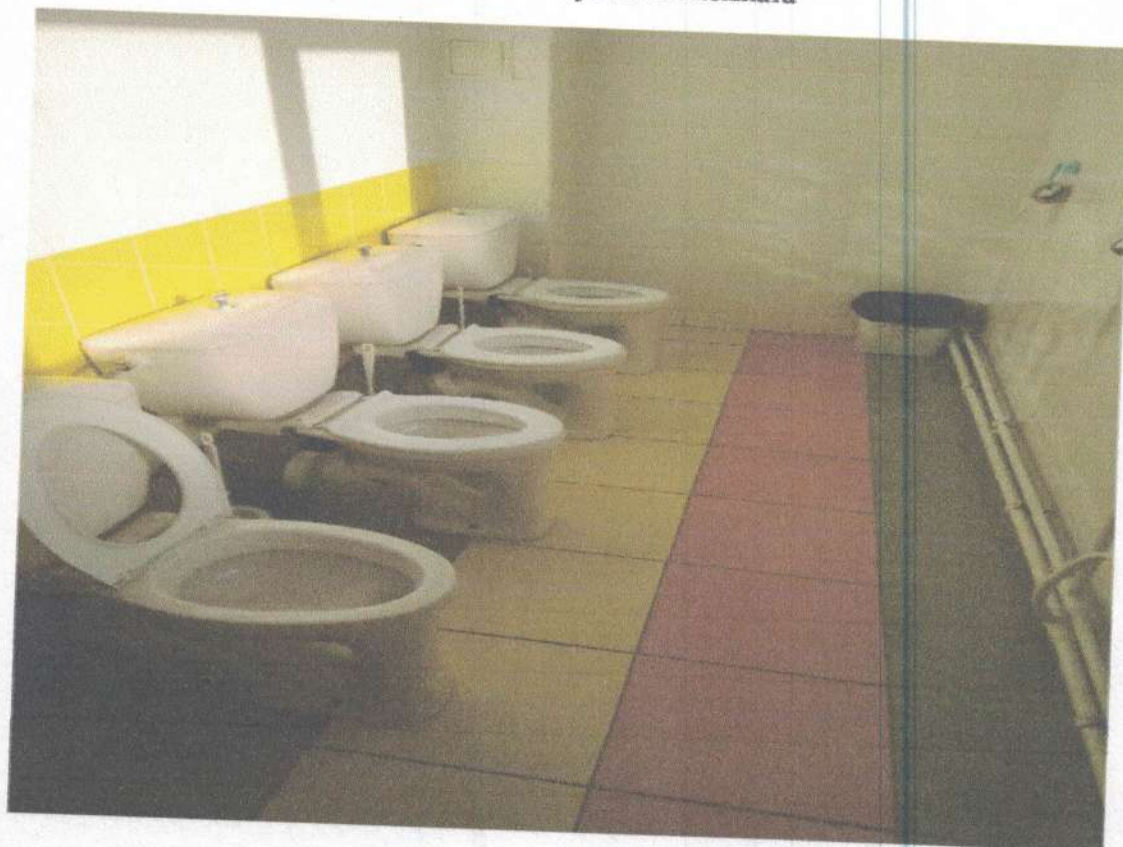
Фото № 24 Туалетная комната
