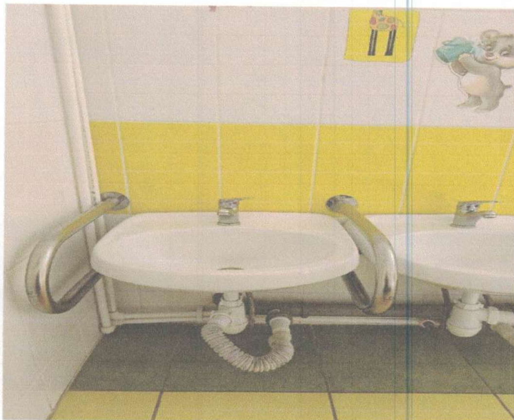
Фото № 35 Туалетная комната
