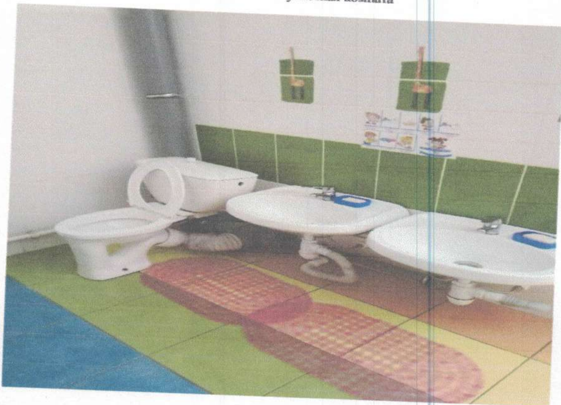
Фото № 23 Туалетная комната
